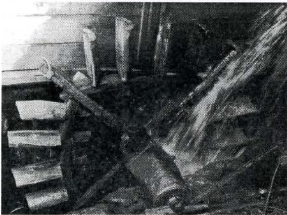
Слика 12. Точак са лопатицама за покрећење ступца за ваљање сукна
